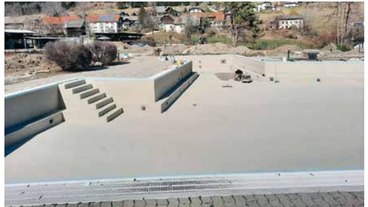
Nach der Entfernung der Beckenfolie wurde festgestellt, dass das darunterliegende Becken abgesciffen und neu gespachtelt werden musste
