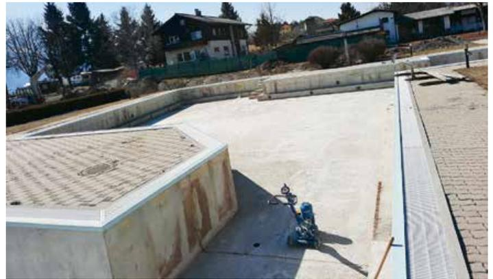
Die Instandhaltungsarbeiten des Beckens umfassten den Austausch der Beckenfolie
